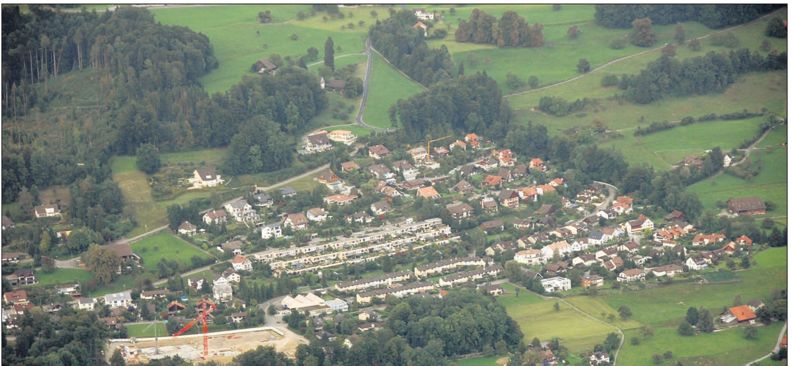
Luftbild aus einem Ballon (2008): östlicher Teil der Breitenmatt, begrenzt durch den bewaldeten Bachlauf, rechts davon Schaufelbergers Scheune, ganz oben die Villen. Im Bau (roter Kran): Siedlungsteil Boostock.
