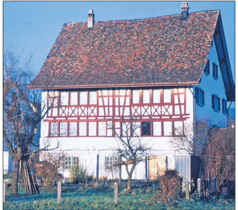
Riegelhaus, Dürnten, von Süden, 1983, nach der Renovation.
