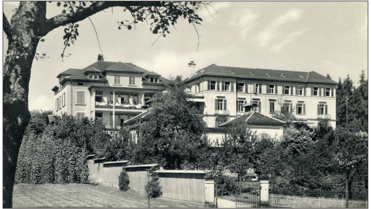
Rütli Krankenhaus (v. l. n. r.) der 1912 erstellte Neubau, der 1912 renovierte Altbau, im Vordergrund das 1904 erstellte Absonderungshaus.
