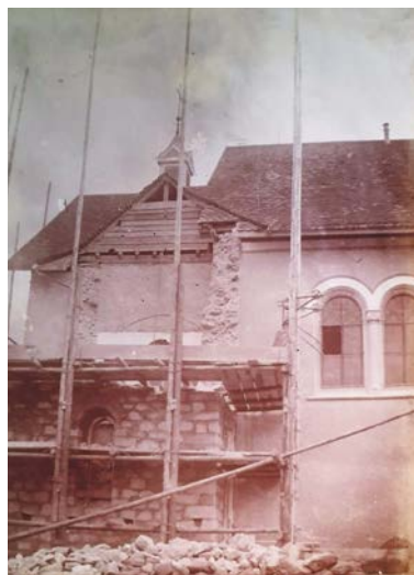
Abriß bis zum Fundament des zu bauenden Turmes.
